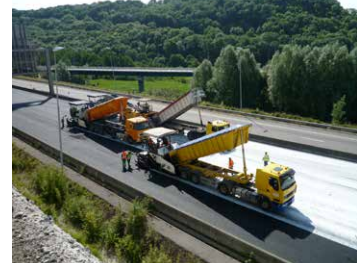
Mise en œuvre d'un enrobé après épandage d'Asphacal® TC
