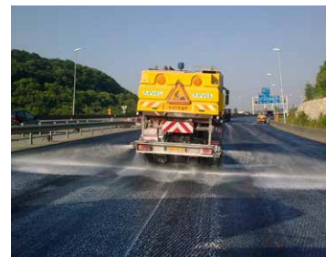
Épandage à la saumureuse d'Asphacal® TC
