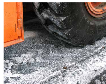
Les pneus ne collent plus à la couche d'accrochage après épandage d'Asphacal® TC
