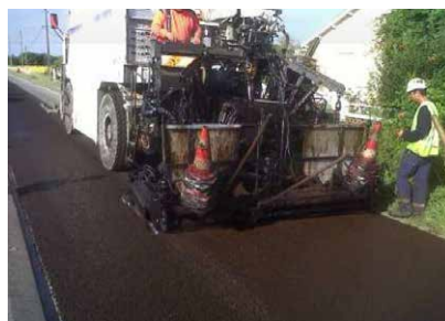
Mise en œuvre de l'ECF
