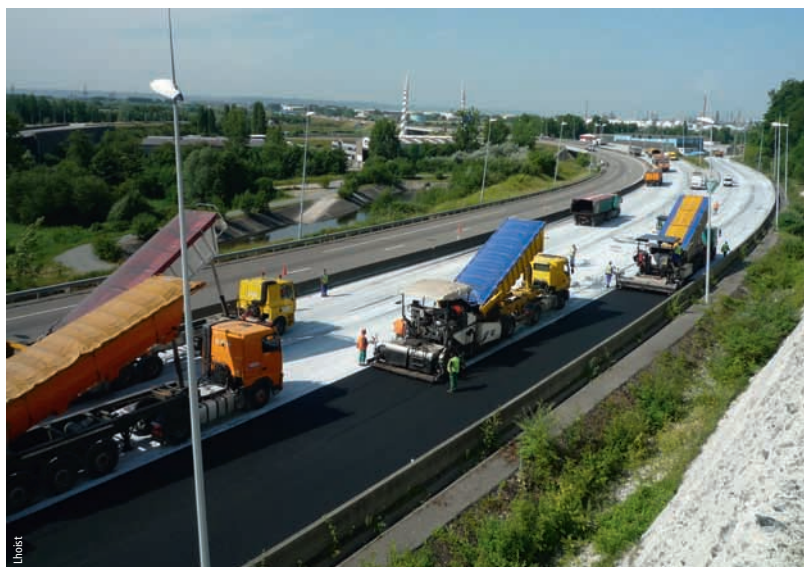
Mise en œuvre d'enrobés sur A29 avec couche d'accrochage traitée au lait de chaux
