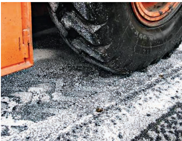
Photo 3 La présence de lait de chaux sur la couche d'accrochage empêche le bitume de coller aux pneus des camions
