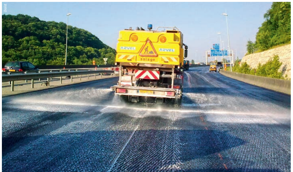
Photo 2 Épandage de lait de chaux dilué Spreading of diluted lime milk
