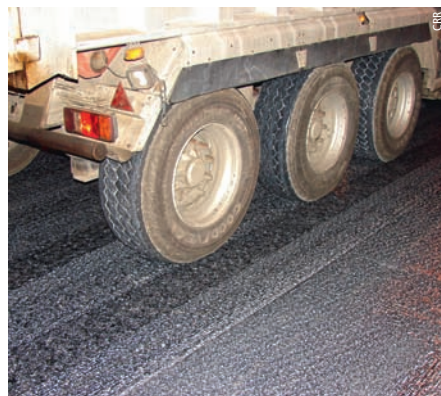
Photo 4 Application du lait de chaux stabilisé dilué sur la couche d'accrochage à 250 g/m 2 de bitume résiduel sur un support fraisé lors du chantier de la N25. A noter : l'absence de traces de bitume sur les pneumatiques du camion Application of stabilised diluted lime milk on tack coat at 250 g/m 2 of residual bitumen on a milled subbase during construction on highway N25. Noteworthy: absence of asphalt traces on lorry tyres
